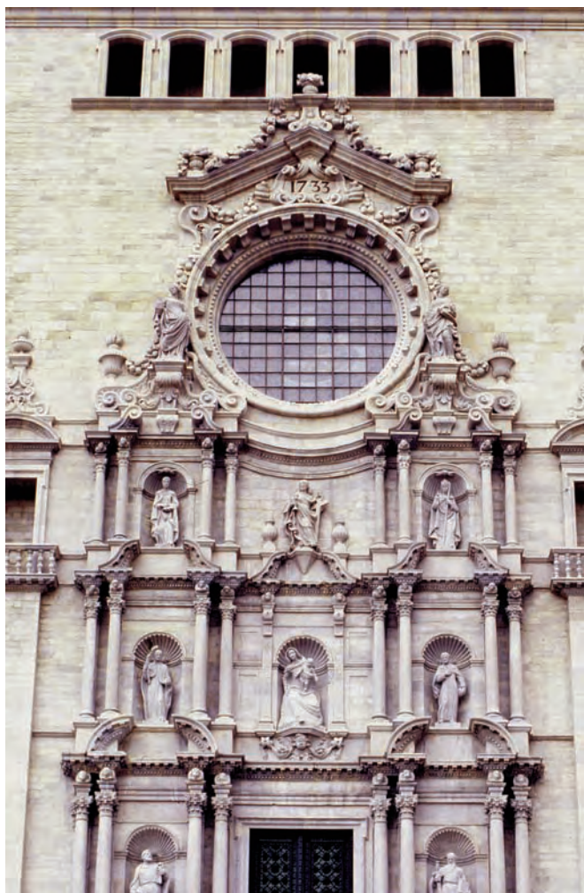
Imagen 20. Fachada principal de la Catedral de Girona. Acristalamiento isotérmico de protección en el rosetón del siglo XVIII.
