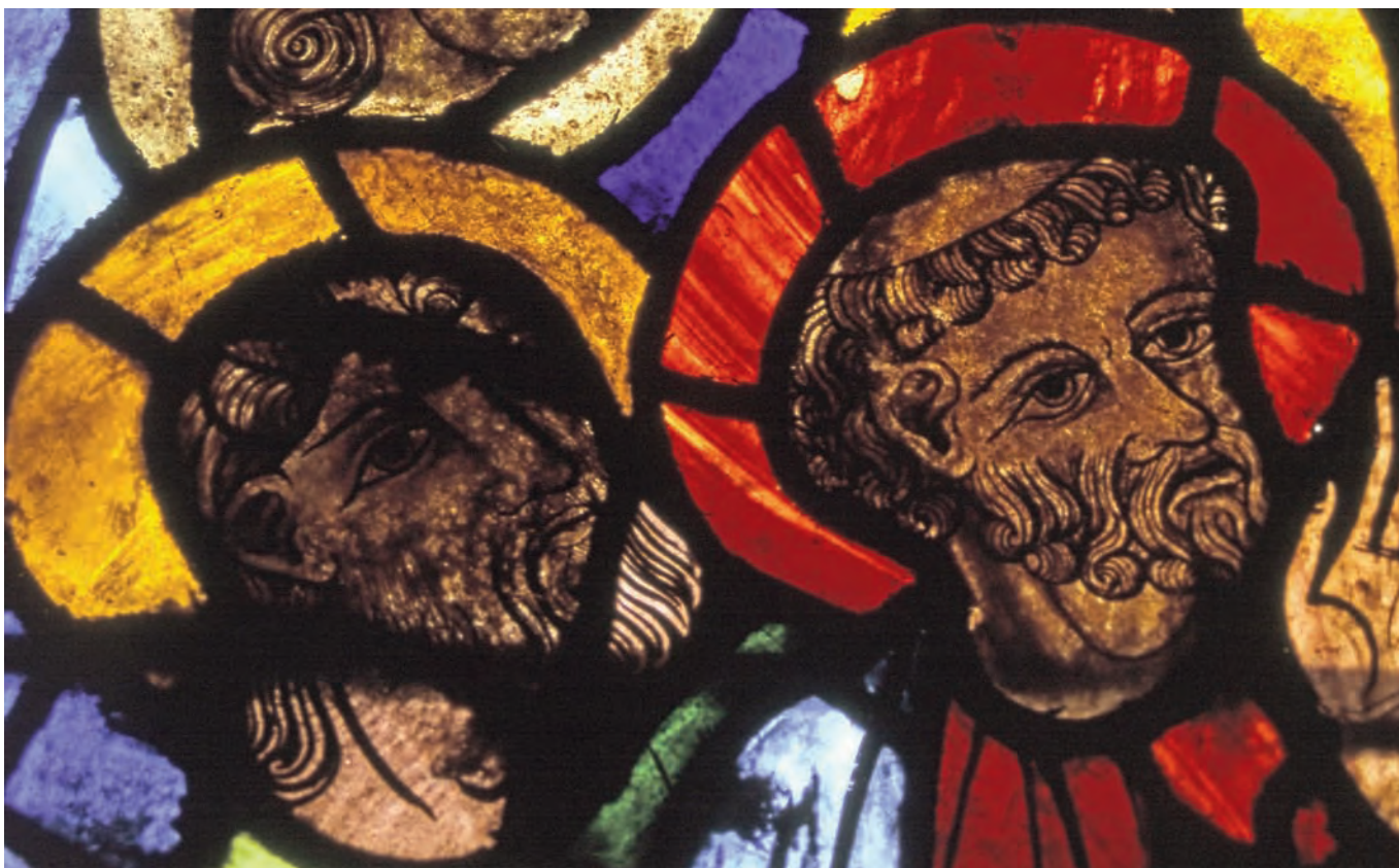
Imagen 9. Catedral de León. Vidriera del siglo XIII de una de las capillas absidiales de la girola. Los rostros de las dos figuras muestran claramente el alarmante cambio de coloración del vidrio producido por el enmarronamiento del manganeso.
