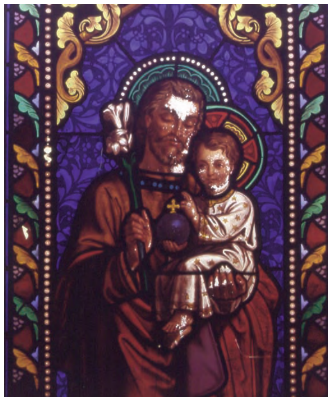
Imagen 12. Iglesia de Magne (Francia). Panel de vidriera realizada por J. P. Florence en el último tercio del siglo XIX, en el cual las pinturas utilizadas en los rostros y manos de ambas figuras muestran un avanzado estado de desprendimiento y pérdida de material.
