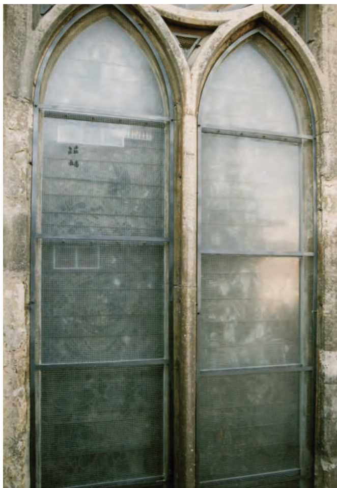
Imagen 15. Catedral de León. Vidriera medieval de una de las capillas absidiales. Colocación de sensores y muestras de simulación en la cámara de ventilación entre el acristalamiento de protección y la vidriera original dentro de un proyecto de monitorización, realizado durante un año completo -entre 1997 y 1998-, de la Temperatura, la Humedad Relativa y del comportamiento de varios paneles-muestra con productos usados en restauración de vidrieras.
