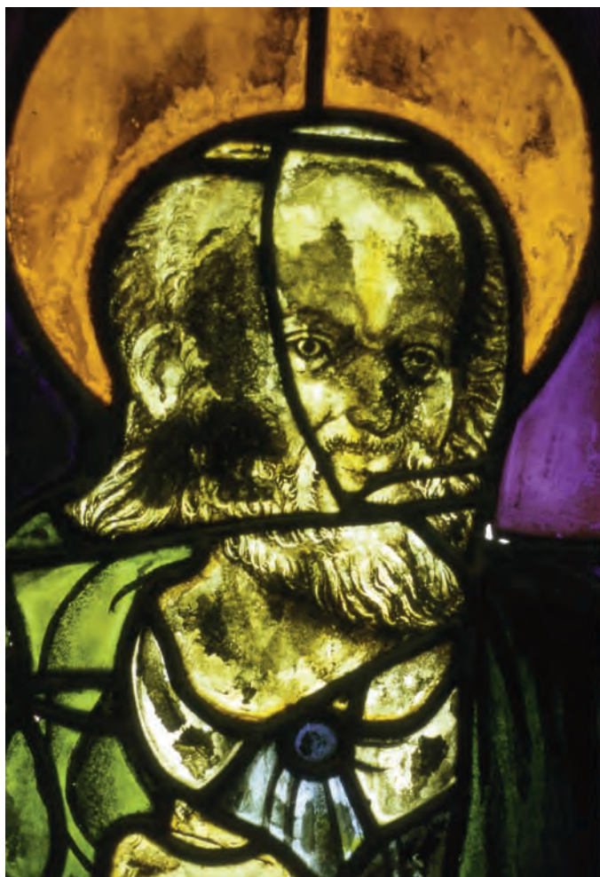
Imagen 19. Catedral de Sevilla. Figura del siglo XVI de una vidriera de la nave central, cara sur. Proceso de limpieza, eliminación de plomos de fractura, pegado de vidrios fracturados y reintegración mediante pinturas en frío de zonas rellenadas con resina.
