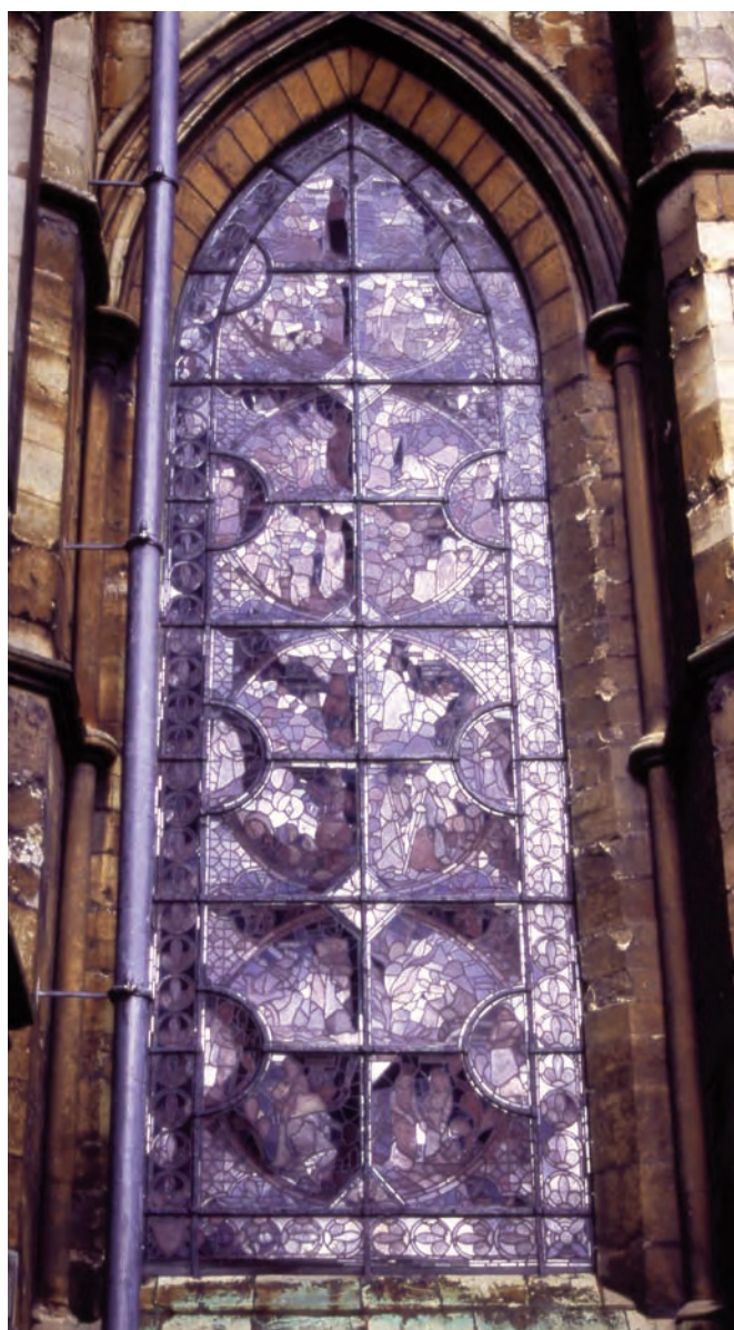
Imagen 10. Catedral de Lincoln (Reino Unido). Vidriera de finales del siglo XIX. En esta imagen se aprecia la grave deformación y abombamiento de la red de plomo de la vidriera debido al envejecimiento de la misma, la fatiga de los materiales y la orientación de la vidriera en la cara sur del edificio.
