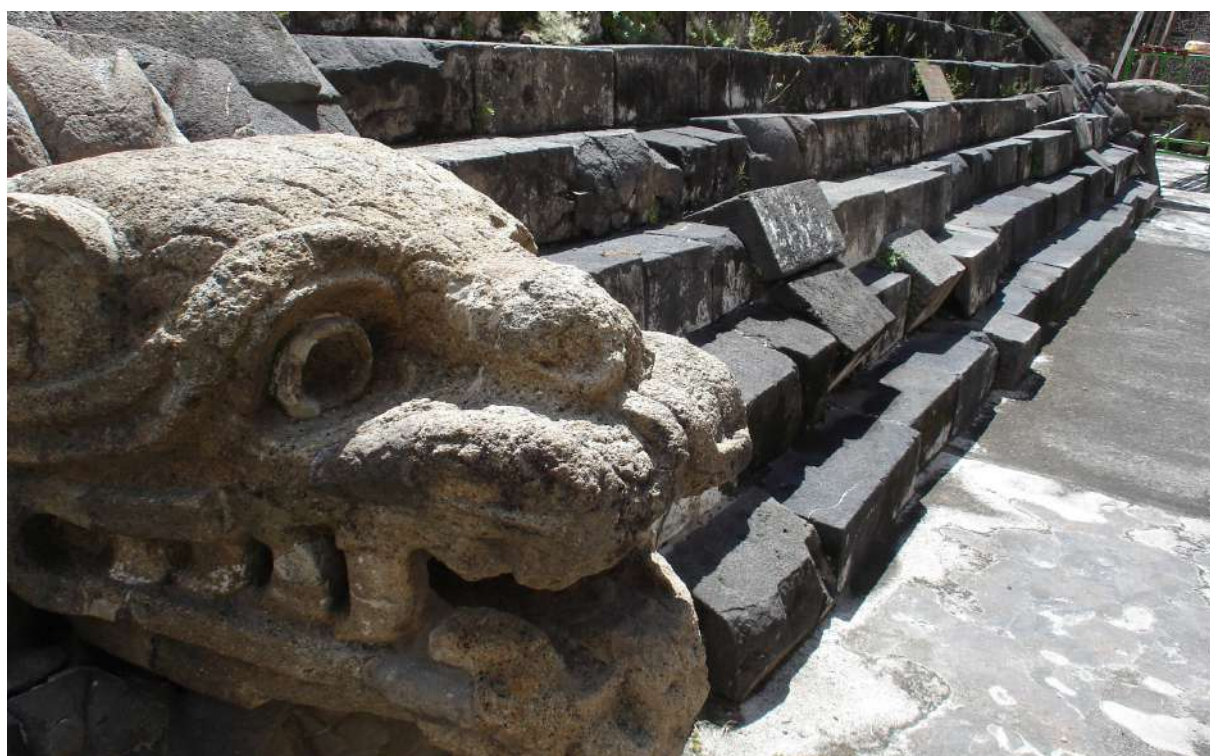
Figura 10. Escalinata de la pirámide de Quetzalcóatl en la Ciudadela de Teotihuacán (México), deformada por efecto de un terremoto. Nótese la extrusión de peldaños y los pliegues horizontales de las hiladas de bloques en cada escalón.
