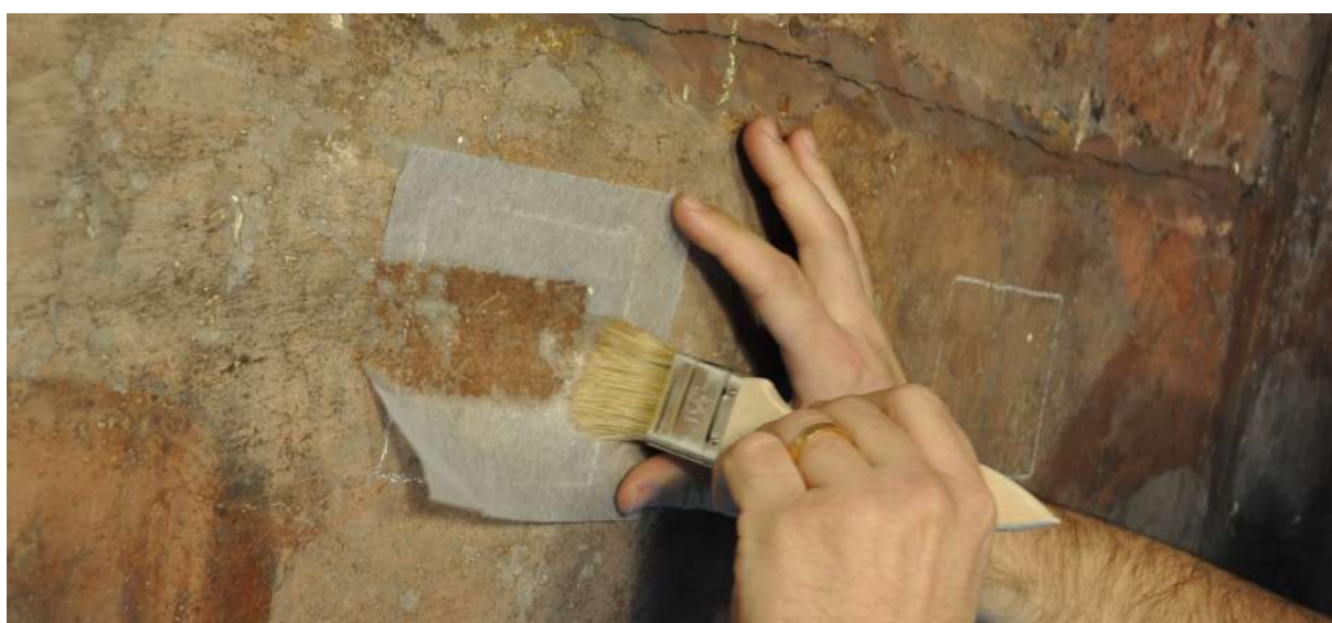
Figura 2. Proceso de aplicación a pincel, sobre papel japonés protector, de la solución bacteriana para la biolimpieza de un fragmento de las pinturas murales de la iglesia de los Santos Juanes de Valencia.
