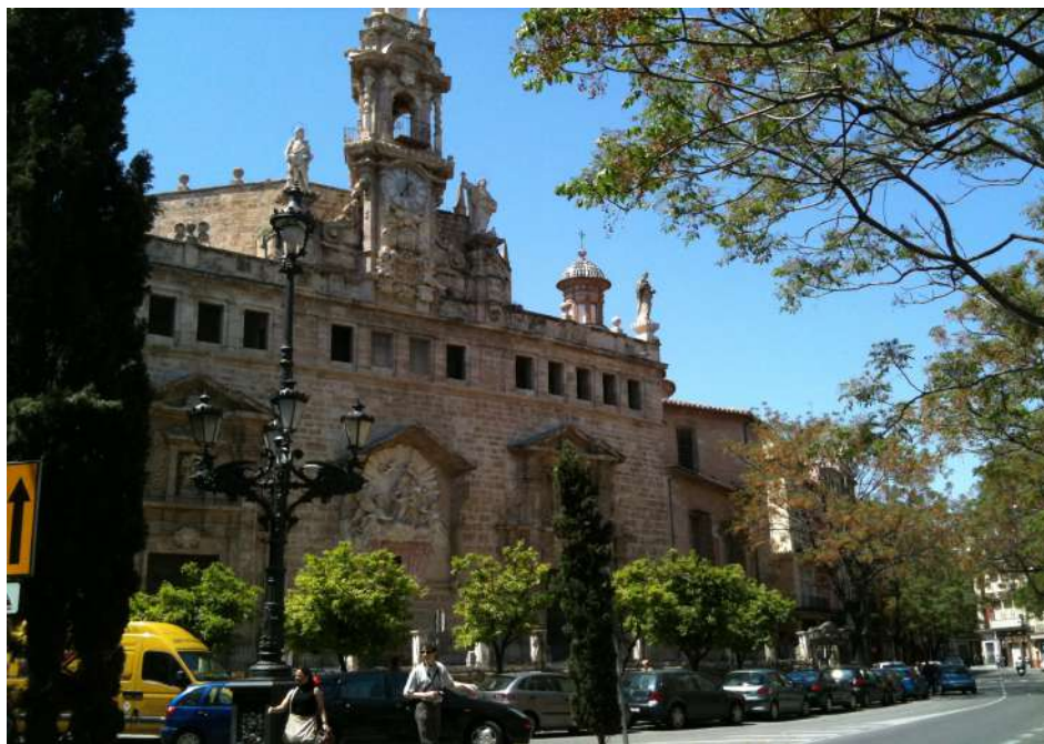
Figura 6. Fachada de la iglesia de los Santos Juanes de Valencia.
