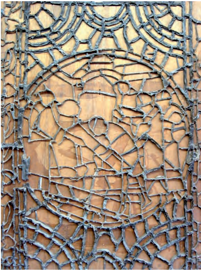
Fig. 18. Red de plomo del siglo XIX de un panel procedente de una vidriera medieval en la Catedral de Lincoln (Reino Unido). (Foto: Fernando Cortés).
