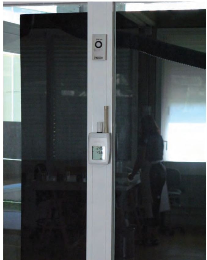
Figura 12. Al igual que la figura anterior (Fig. 11), se puede ver un sensor de seguimiento por radio-frecuencia de humedad relativa y temperatura, en la Sala Acondicionada 2, y un data-logger de iluminancia.
