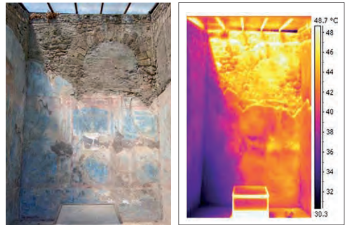
Figura 9. Casa de Ariadna.; a) Exedra 22 con pintura mural y mosaicos en el suelo con el emblema en opus vermiculatum.; b) Estudio termográfico de las estructuras y de las superficies.
