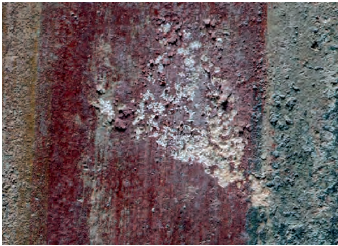
Figura 12. Pintura mural en la Oecus 17. Se observa el grave estado de alteración de la superficie decorada debido fenómeno de desprendimiento de la capa pictórica provocado por procesos de cristalización y recristalización de las sales.
