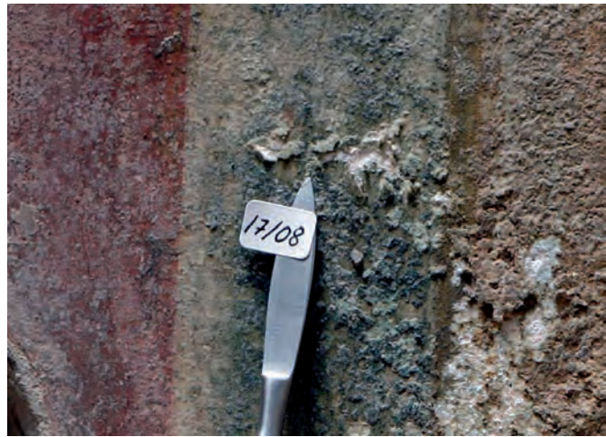
Figura 12. Pintura mural en la Oecus 17. Se observa el grave estado de alteración de la superficie decorada debido fenómeno de desprendimiento de la capa pictórica provocado por procesos de cristalización y recristalización de las sales.
