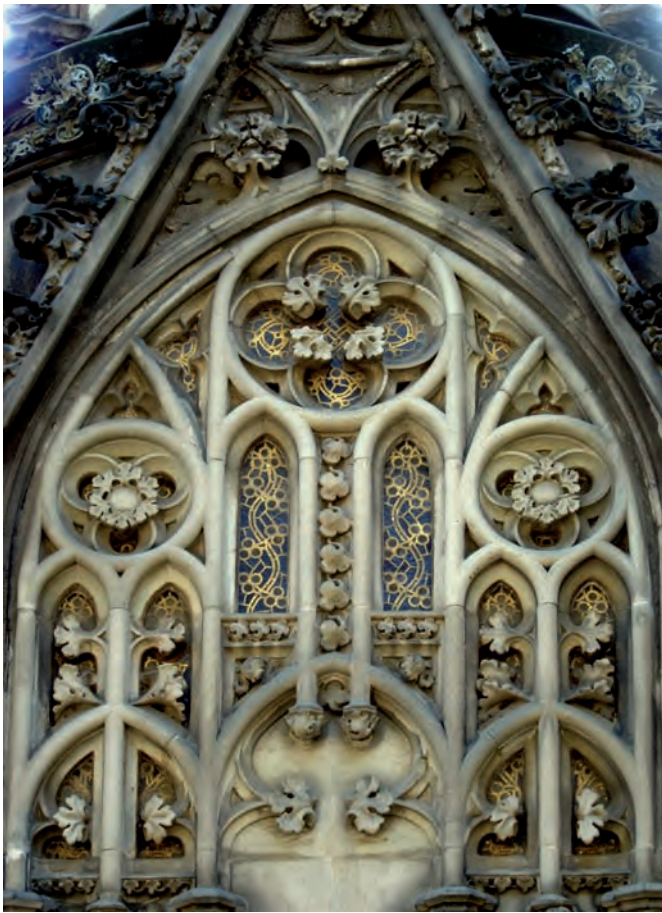
Fig. 8. Vidriera de finales del siglo XIX o principios del siglo XX situada en un mausoleo del Cementerio de Montjuic Barcelona) en la cual se han pintado de dorado los plomos exteriores. (Foto: Silvia Cañellas).
