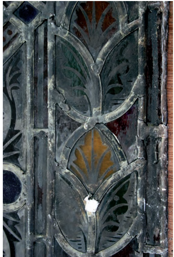
Fig. 17. Detalle de varias fracturas en la red de plomo del panel de una vidriera de finales del siglo XIX en la fachada principal de la Catedral de Barcelona. (Foto: Fernando Cortés –Teodoro Fort).
