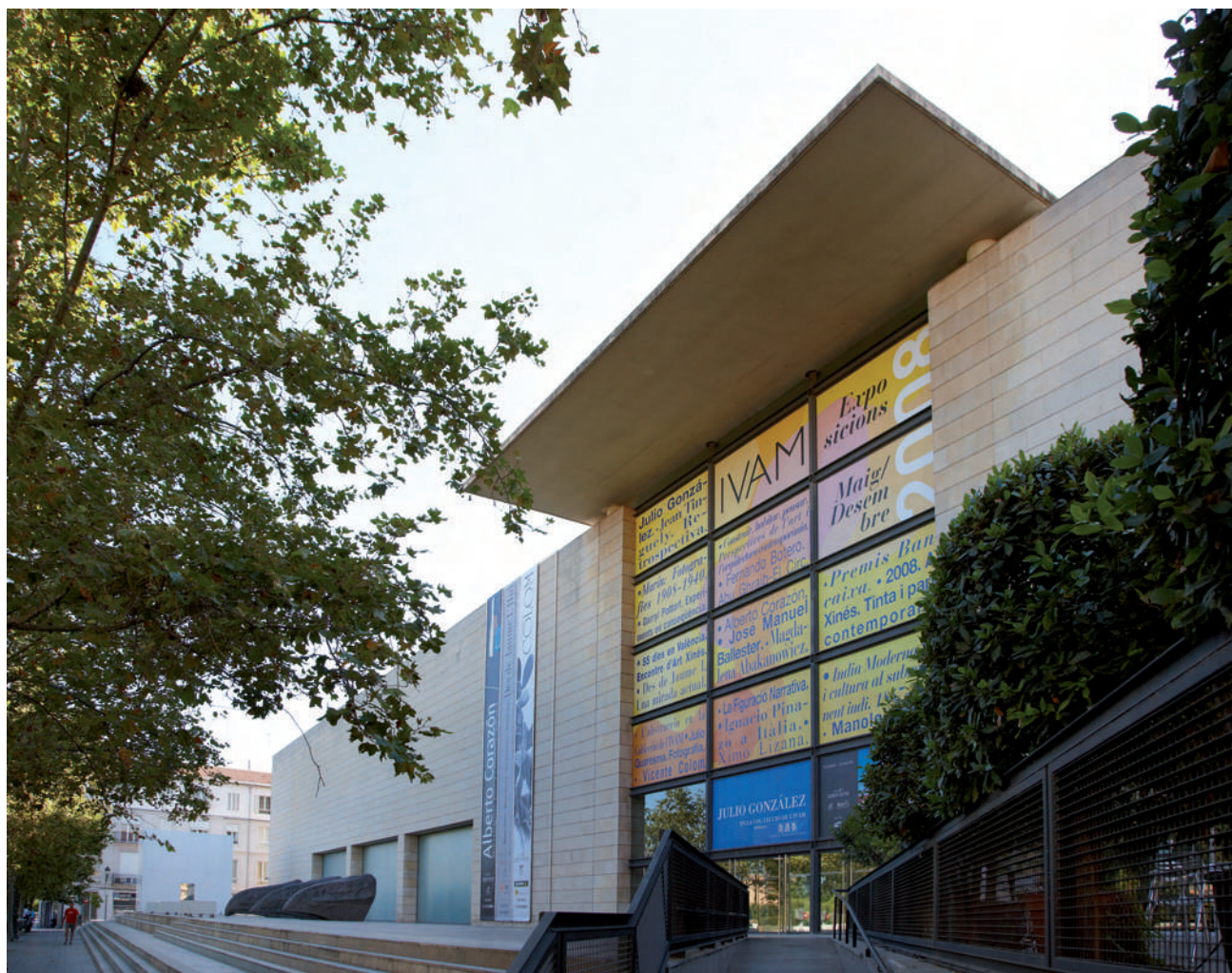
Figura 1. Fachada del IVAM. Foto: IVAM.
