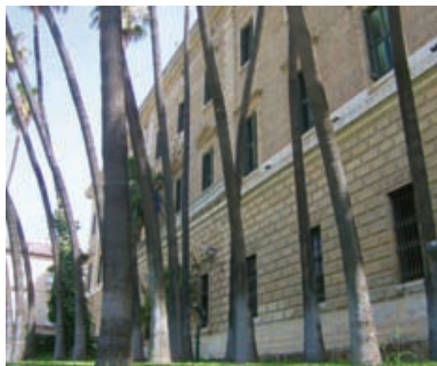
Figura 8. Palacio de la Aduana, edificio destinado a sede del Museo de Málaga, que ha redactado y aplicado su programa arquitectónico en la elaboración de un proyecto de ejecución. Foto: V. Cageao.
