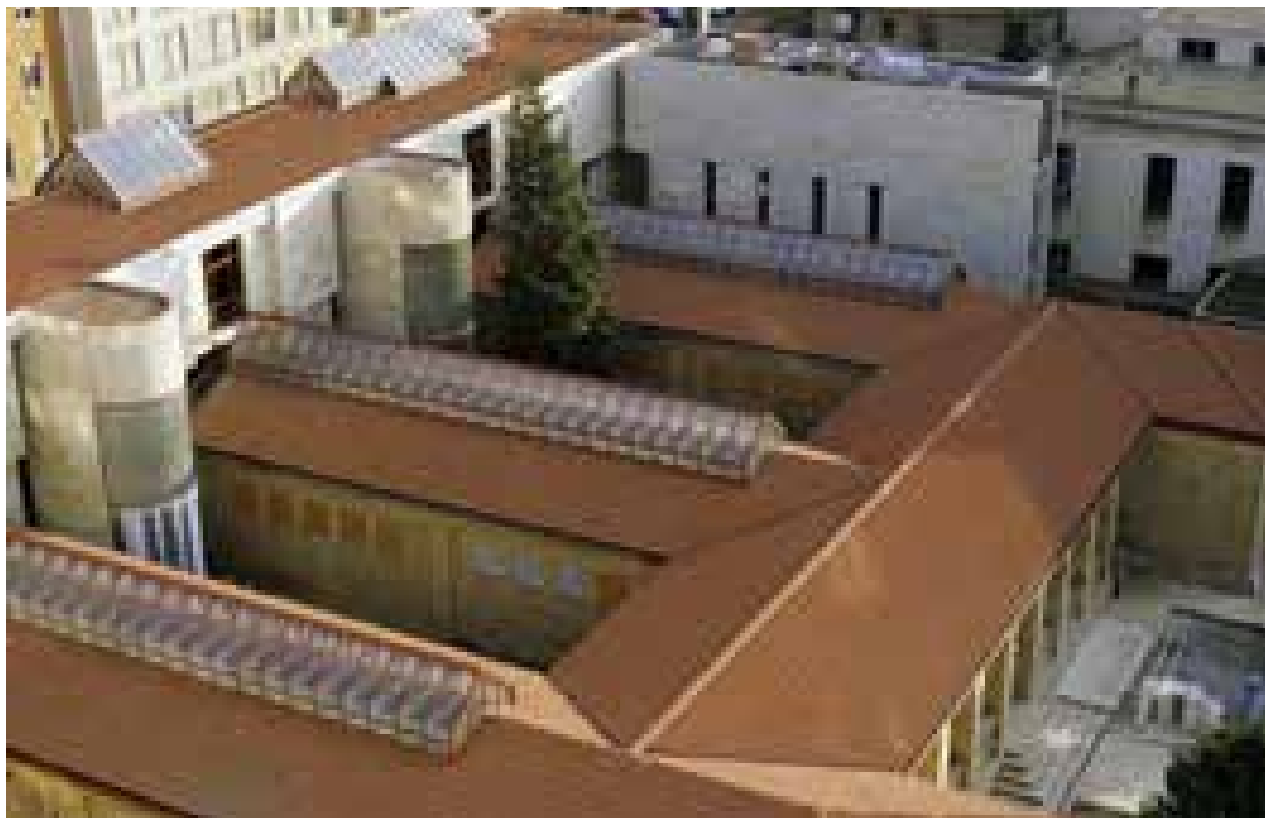
Figura 4. El Museo Numantino durante la realización de las obras.
