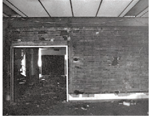
Figura 2. Vista parcial después de retirar el mural.
