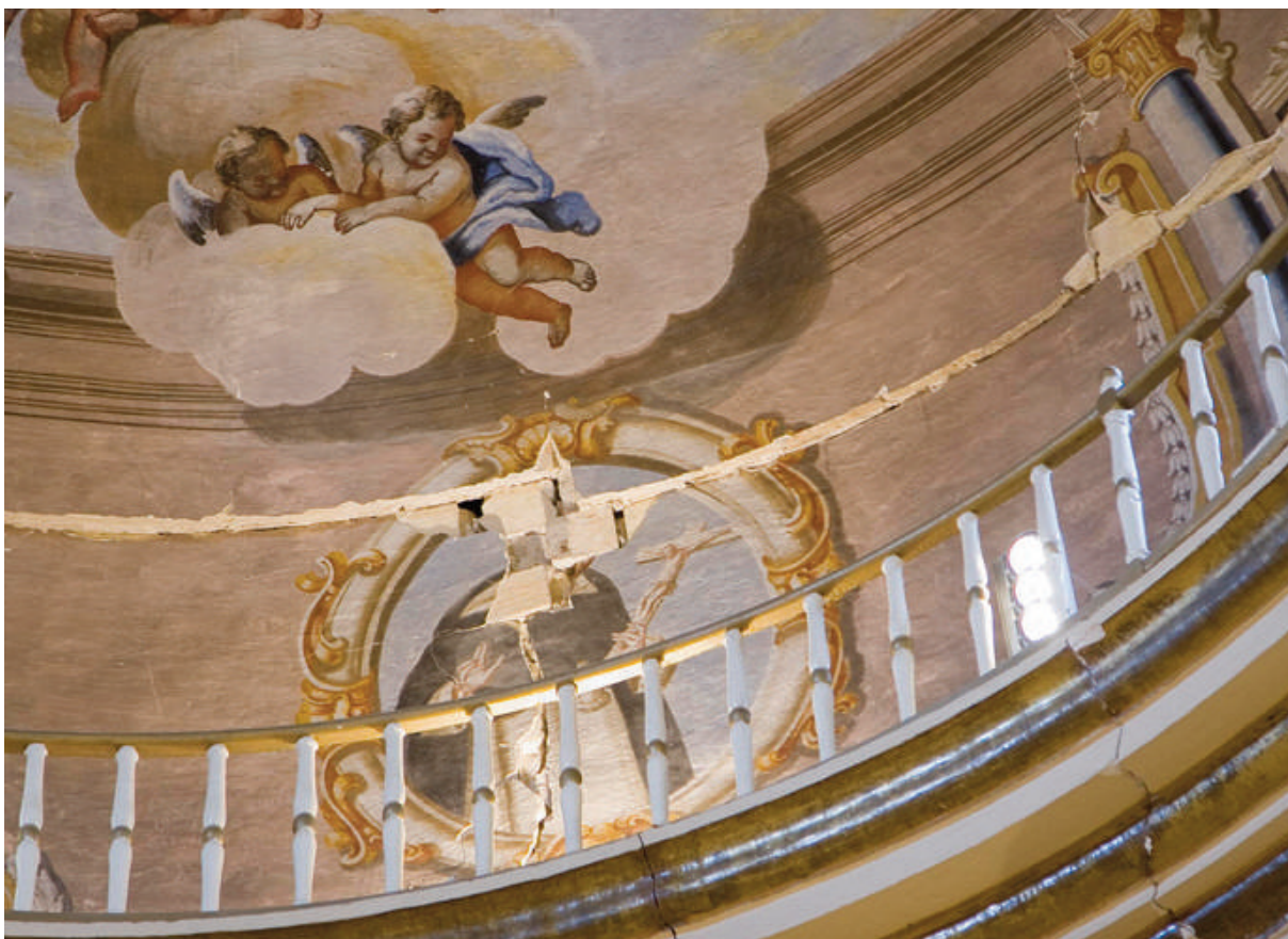
Figura 2. Detalle de los daños que presenta la cúpula de la iglesia de Santo Domingo, donde no solo se ha desprendido el estrato pictórico, sino también los estratos inferiores.
