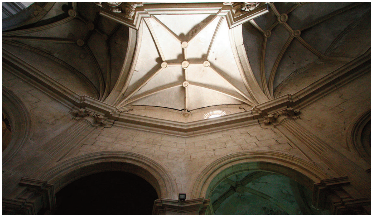
Figura 3. Colegiata de San Patricio. Separación de las bóvedas de un tramo de la girola por vuelco del muro de cierre.
