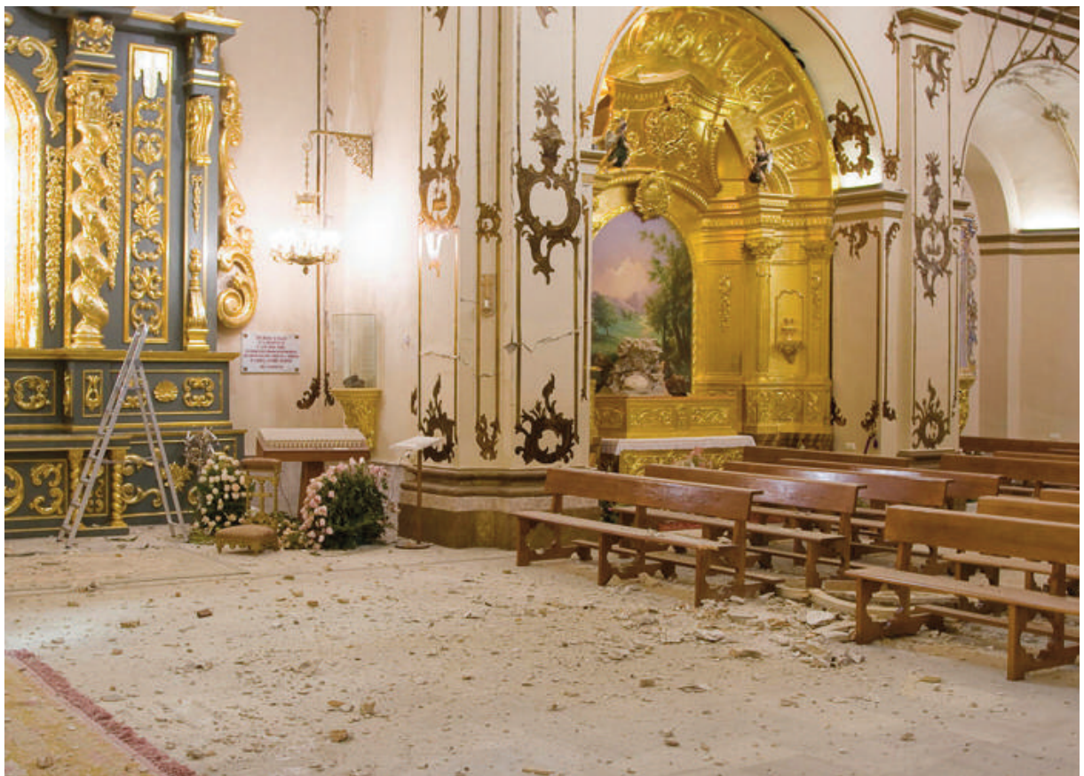
Figura 1. Interior de la iglesia de Santo Domingo tras los seísmos.
