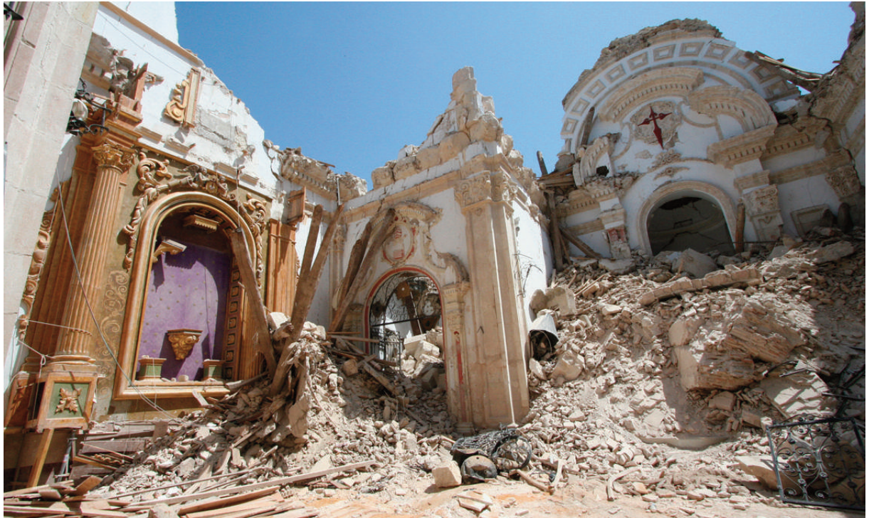
Figura 4. Iglesia de Santiago. Colapso del crucero con el desplome de la cúpula, bóvedas, arcos del crucero y cubiertas.
