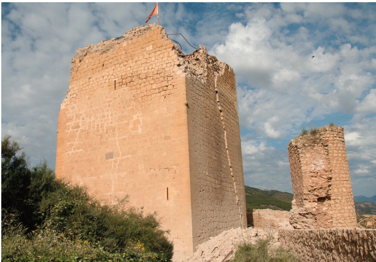
Figura 1. Torre del Espolón. Fractura de la esquina NO y desplome de la fábrica de mampostería de coronación con rotura de la cubierta.
