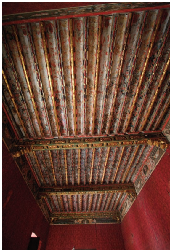
Figura 5. Casa Guevara. Desprendimiento de capa pictórica de los revoltones del techo de madera tallada y dorada.
