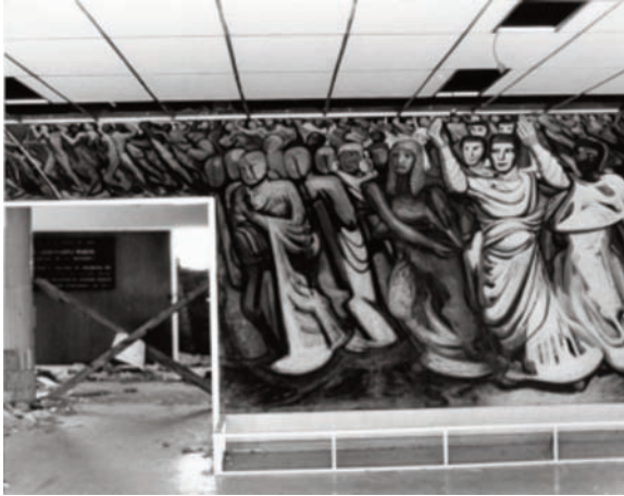
Figura 1. Vista parcial de las condiciones de la obra antes de su retiro.
