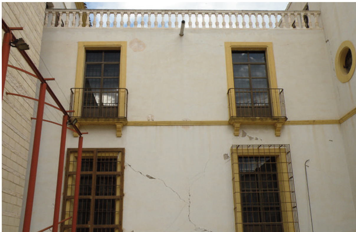
Figura 2. Desperfectos y aspa en la fachada del patio del Museo Arqueológico Municipal de Lorca.
