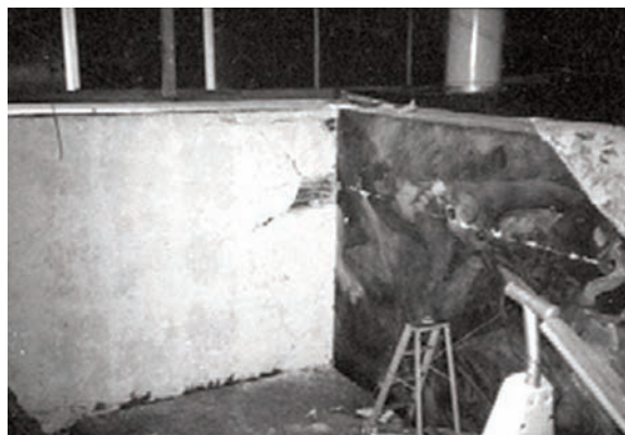
Figura 4. Vista general del proceso de retirada del mural.
