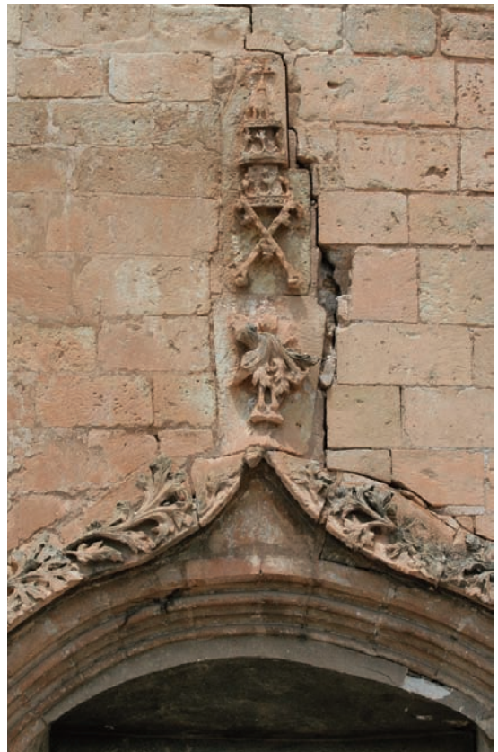
Figura 2. Iglesia de San Pedro. Juntas de sillares abiertas en la portada.
